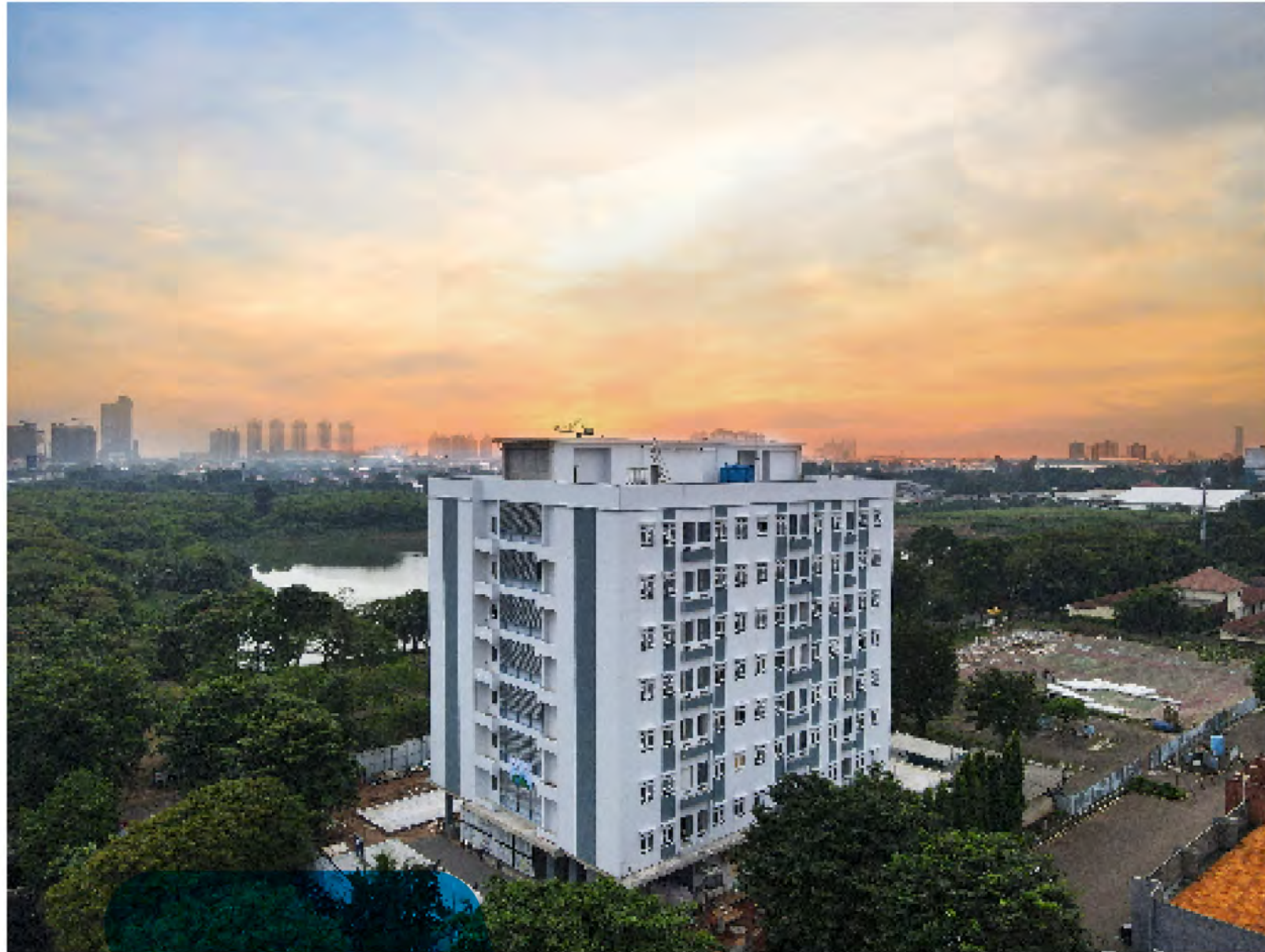
Rumah Susun Bertingkat Tinggi Mahkamah Agung
